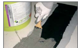
7 Para un acabado general puede aplicarse AT IMPER TT en toda la superficie a impermeabilizar
