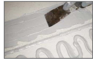
2 Espatular los cordones de masilla para un perfecto sellado
