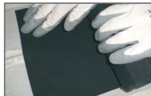
3 Extender la banda presionando para favorecer el correcto anclaje
