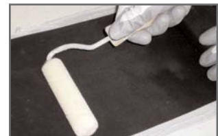
4 Presionar con la ayuda de un rodillo para asegurar un buen reparto de la masilla
