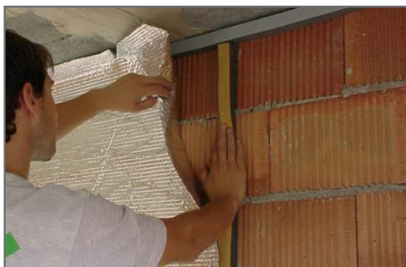
AT ARCOCAMARA es ideal para la instalación rápida y sencilla de láminas aislantes tipo AT K-THERM.
