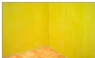
Permitir el secado según su uso como imprimación (máximo 15 mins.) o como adhesivo (24 horas)
